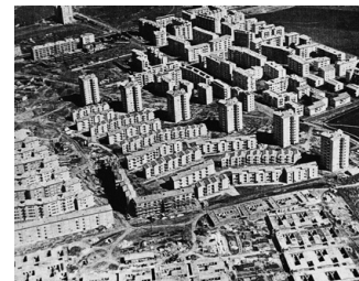
11. Veduta aerea del quartiere 'Tuscolano' a Roma; in basso la 'casbah' dell'unità d'abitazione orizzontale progettata da A. Libera, 1949-54.
