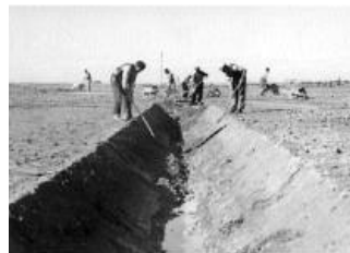
1. Lavori nei fossati di scolo nella bonifica a Torre di Zuino.
