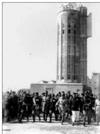
5. La torre per il bisolfite il giorno dell'inaugurazione dello stabilimento.
