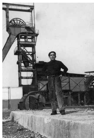
3. Operaio in posa davanti al castello del pozzo.
